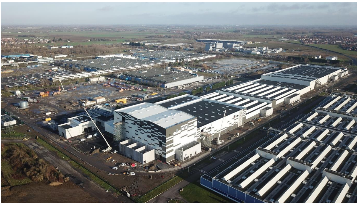
Costruzione della Gigafactory di Billy-Berclau, sito di Douvrin
